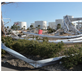
津波で壊滅的な被害を受けたガス局港工場
